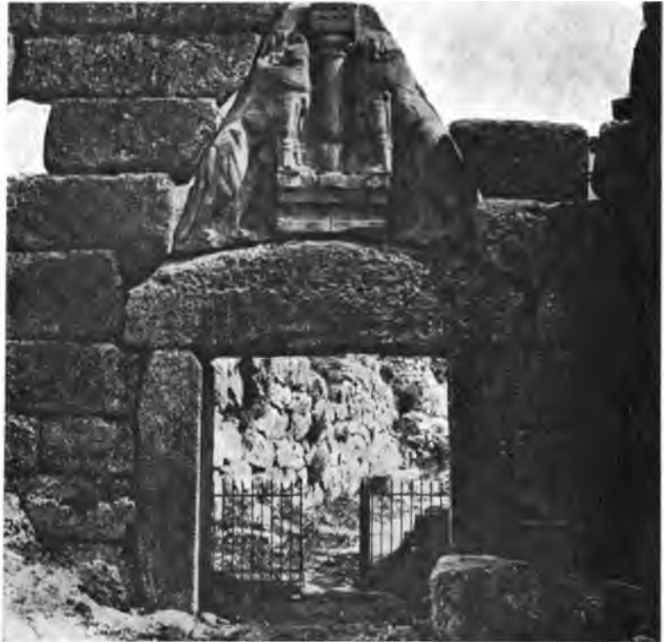
Fig. 56. — Porte des lions à la citadelle de Mycènes. Encorbellement déchargeant le linteau.
